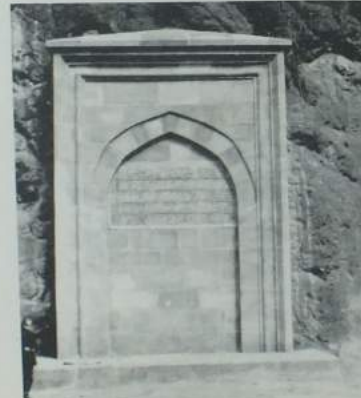
Osmançık Koyunbaba Köprüsü Kitabesi Inscription on the Osmançık Koyunbaba bridge. Inscription sur le pont de Koyunbaba à Osmançık. Inschrift der Brücke von Osmançık-Koyunbaba.
