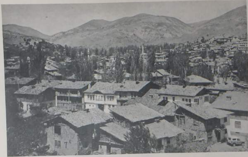
Işıkli İlçesi Genel Görünüşü
