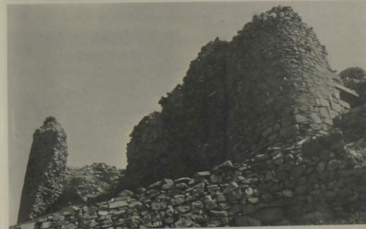
İskilip kale duvarları Walls of the Iskilip Castle. Murs de la Forteresse d'Iskilip Mauern der Festung von Iskilip
