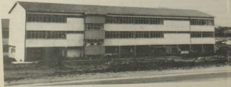
yapımı devam etmekte olan İlköğretim Okulu Dershane Binası
