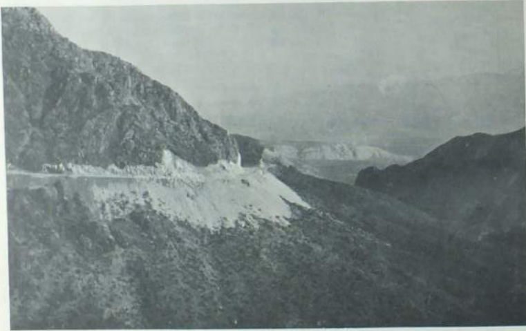
Çorum - Osmancık yolu üzerinde Kırkdilim boğazında açılacak yeni yol çalışmaları
