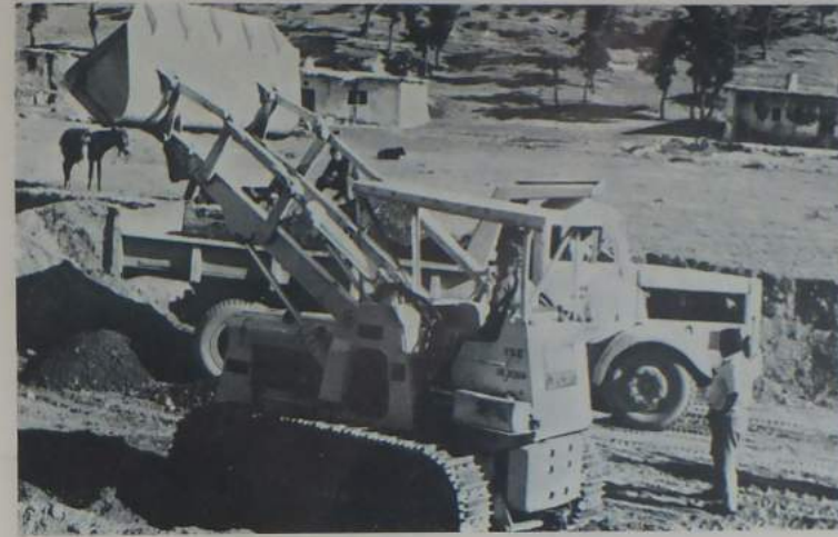
Yol-Su-Elektrik Müdürlüğü çalışmaları
