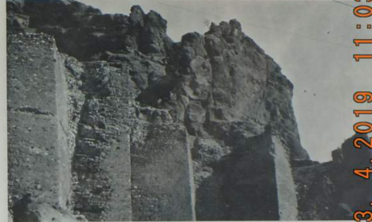
Osmançık kale duvarları Walls of the Osmançık Castle. Murs de la Forteresse d'Osmançık. Mauern der Festung von Osmançık.
