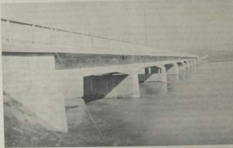
Çorum İskilip yolu üzerindeki kızılirmak köprüsü
