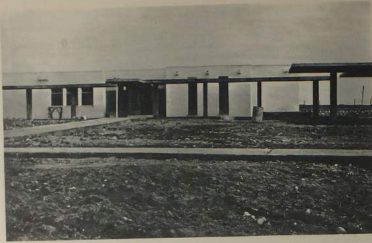
Yapımı bitmek üzere olan Çorum Müzesi The Çorum museum about to be completed. Musée de Çorum en construction
