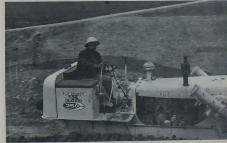
Yol-Su-Elektrik müdürlüğü çalışmaları
