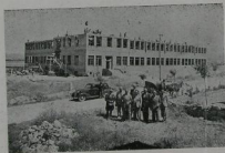
Çorumda yapilmakta olan orta okul binası
