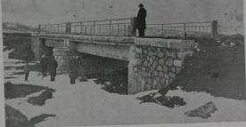
Çorum - Merzifon yolunun 21+500 km 'indeki Döğenci köprüsü 18-2-36
