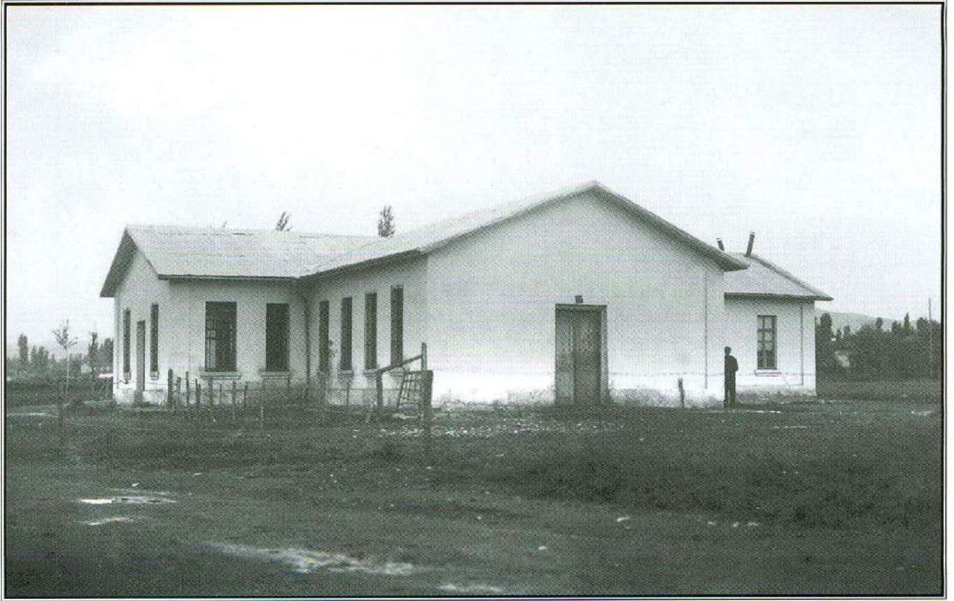
1930'lu yıllar Mezbanhanın dıştan görünümü(Eşref Ertekin Arşivi) Exterior of the slaughterhouse. 1930s
