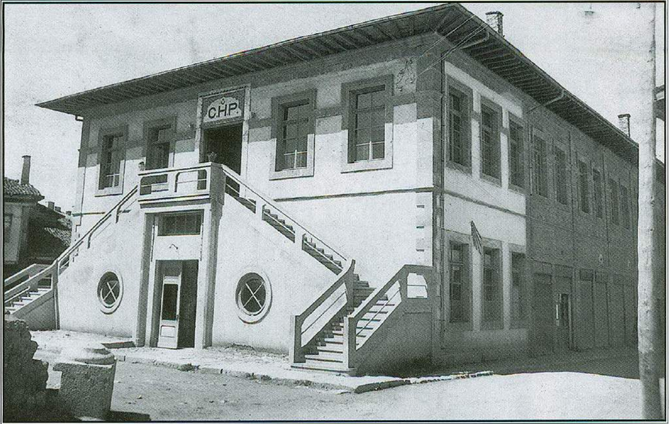
1950'li yıllar günümüzdeki Belediye Binası, beyaz boyalı bölüm sonradan binaya eklenen kısım. (Eşref Ertekin Arşiv)
