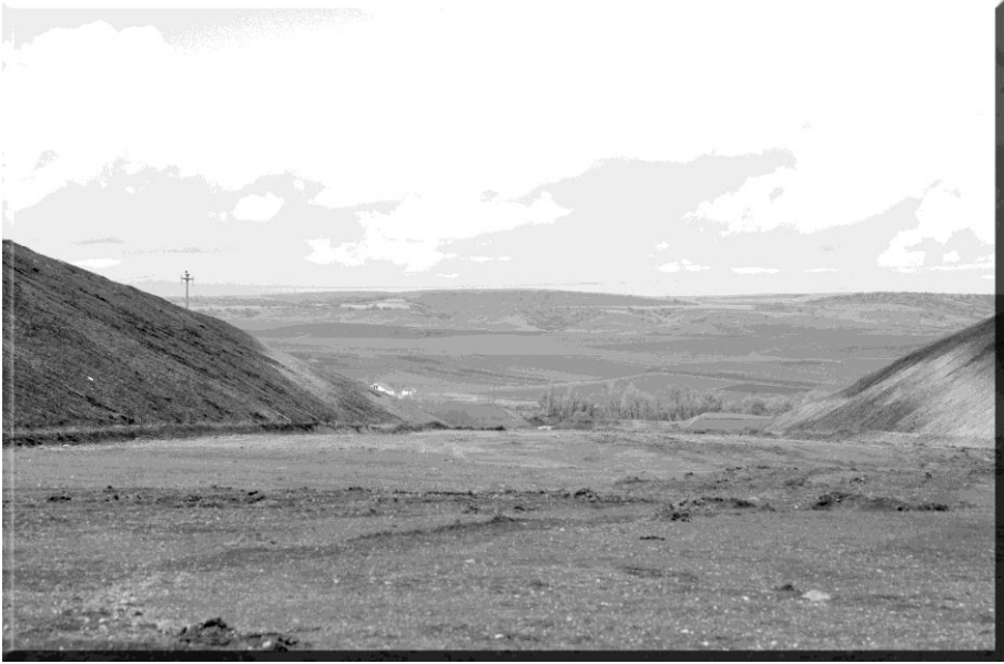
Eskiyapar-Perçem toprak yolu arasında doğu-batı yönünde yapılan yol çalışmaları.
