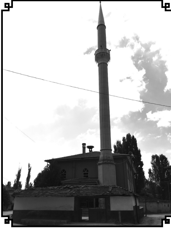
Beydili Köyü Camii
