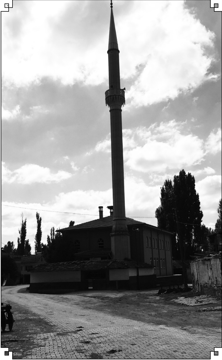
Beydili Köyü Camii
