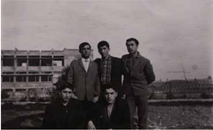
Arkada Tedrisat binası İnşaat Halinde
