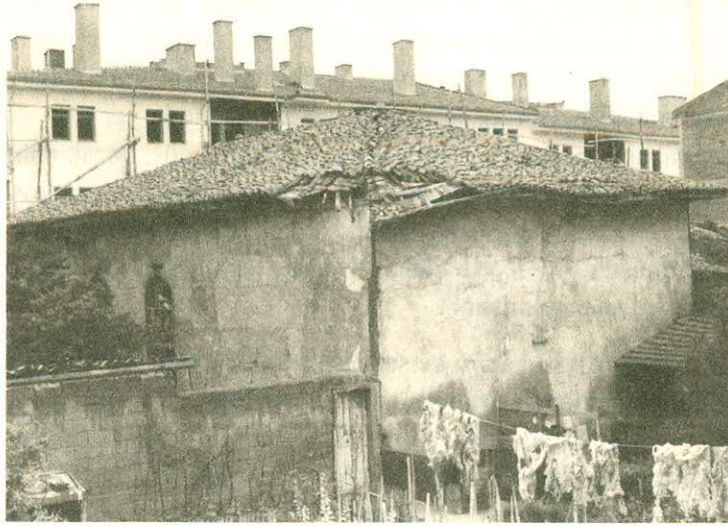
Mevlevihânenin restore edilmeden önceki görünümü (Kent Arşivi)
