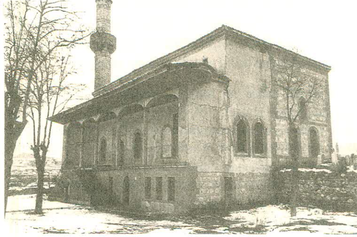
Hıdırlık Camii ve Türbesi son cemaat yeri ve batı cephesinden görünüşü (A. DüNDAR'dan)
