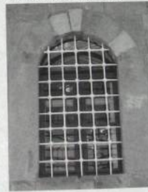
Pencerelerden birisinin dıştan görünümü
