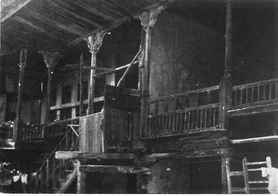
Celepziade evinden ön görünüş.
