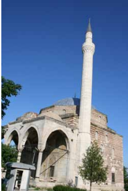
38- Üsküp Mustafa Paşa Camii'nin Restorasyon Sırasındaki Görünümü
