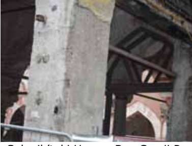
34- Selanik'teki Hamza Bey Camii Restorasyonunda Betonarme Taşıyıcılar
