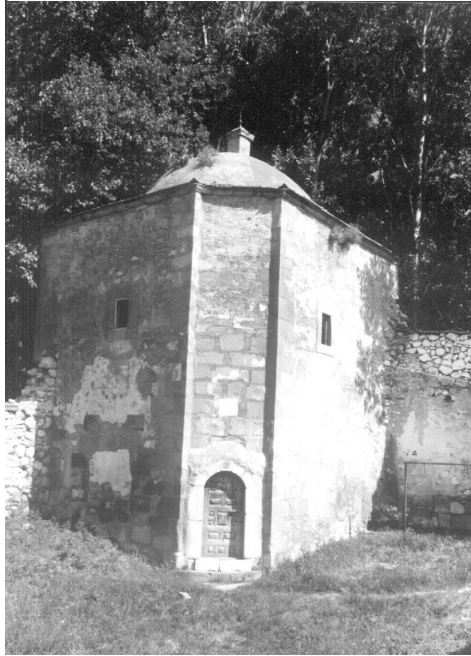
Hüseyin Gazi Külliyesi ve Türbesi
