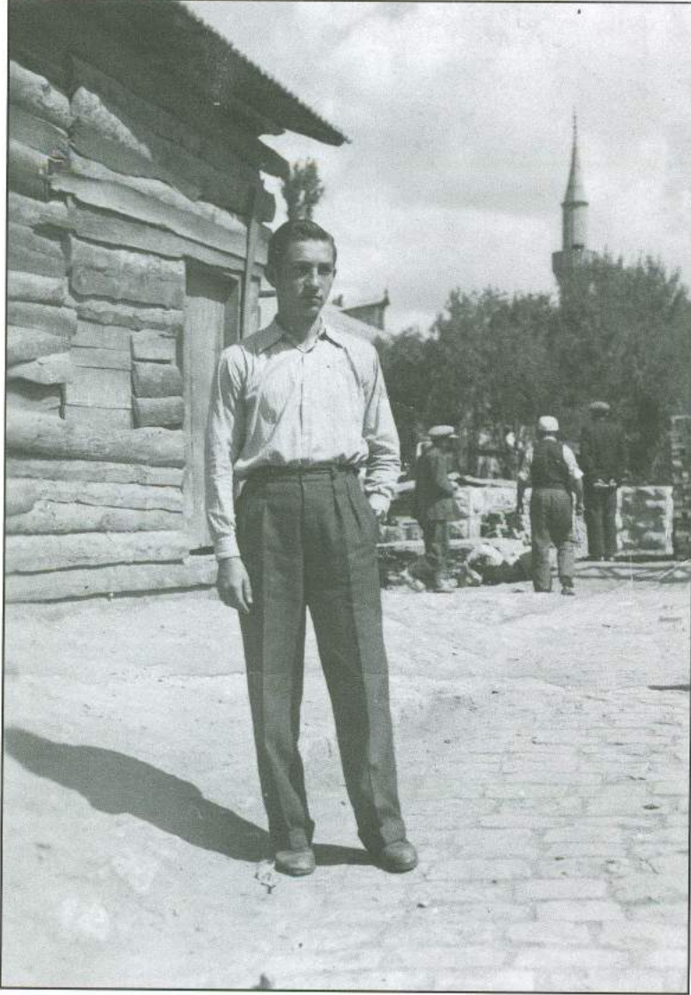
1952 yılında Ziraat Bankası yapılırken . Kaleli apartmanı yokken. (Arkada Ulu Camii.) (Resim: San Mustafa-Terzi)
