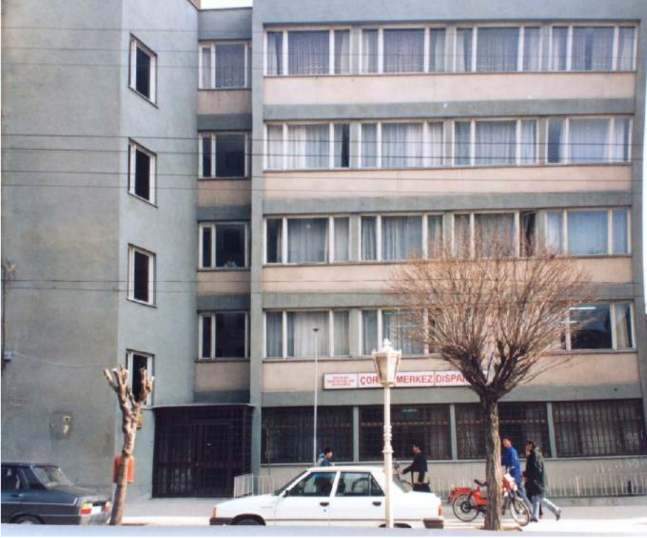
Resim: 1995- SSK'ya bağlı Dispanser binası. Gazi Caddesi üzerindeki bu bina yıkılmış ve büyük bir giyim mağazası inşa edilmiştir.
