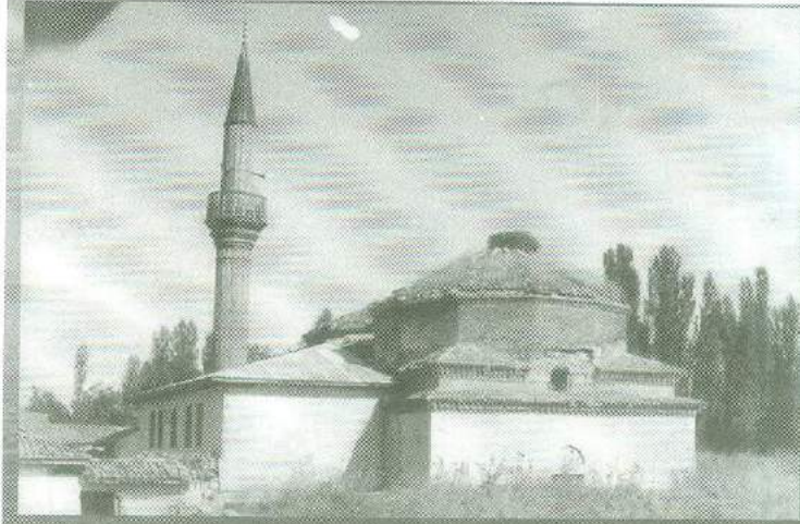
Fotoğraf: 15-Abdal Ala Zaviyesi'nin Kuzeybatıdan Görünüşü (VGM Arşivinden)
