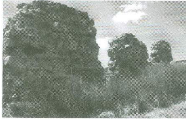
Resim:4 Cemilbey Köyü Camisi. Doğu cephesinin güneydoğudan görünümü.
