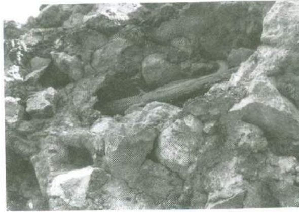
Resim:14 Cemilbey Köyü Camisi. Güney duvarından diğer ayrıntı.
