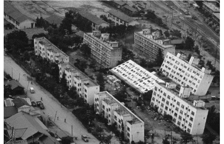
1964 Niigata depreminde Kawagishi-cho sitelerinde sıvılařmadan ileri gelen taşıma kapasitesi yenilmeleri
