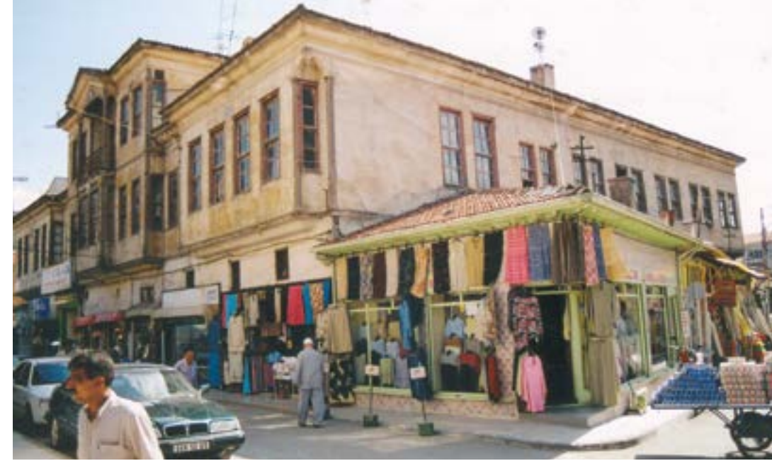
Resim 2. Velipaşa Hanı’nın Kuzey cephesi (2008) (Ö. İ. Tuluk arşivi)
