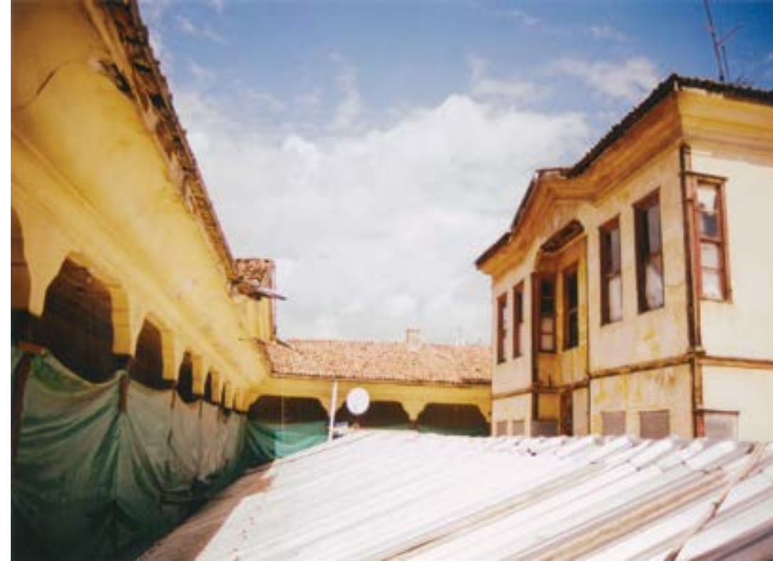
Resim 7. Han'ın restorasyon öncesi (2008) çelik strüktürlü çatıyla örtülmüş orta avlu boşluğu (Ö. İ. Tuluk arşivi)
