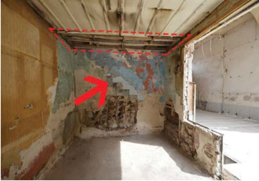
Resim 22. Tavan ve duvar yüzeyinde merdiven izleri (ARK. LTD.–AFE LTD. Ortak Girişimi arşivinden yeniden işlenerek)
