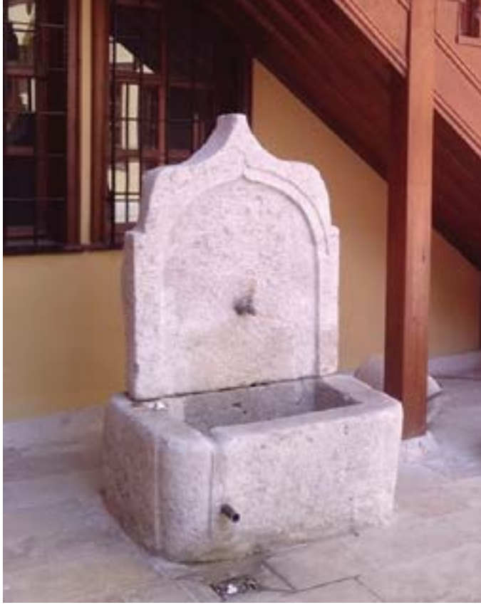
Resim 17. Restorasyon sonrası çeşme (H. Tuluk arşivi)
