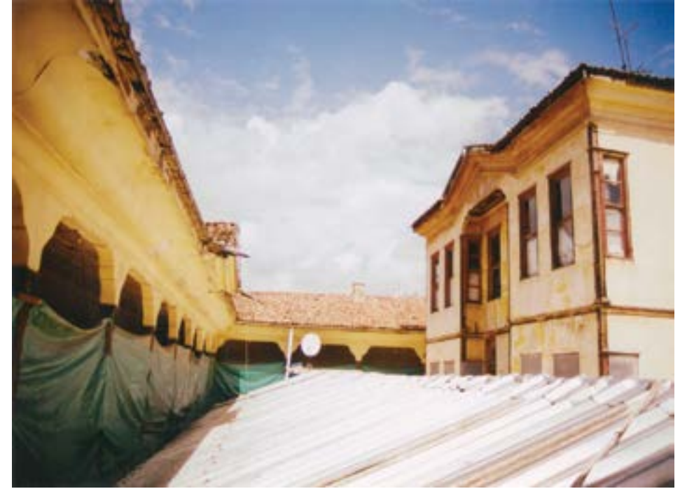
Resim 7. Han'ın restorasyon öncesi (2008) çelik strüktürlü çatıyla örtülmüş orta avlu boşluğu (Ö. İ. Tuluk arşivi)
