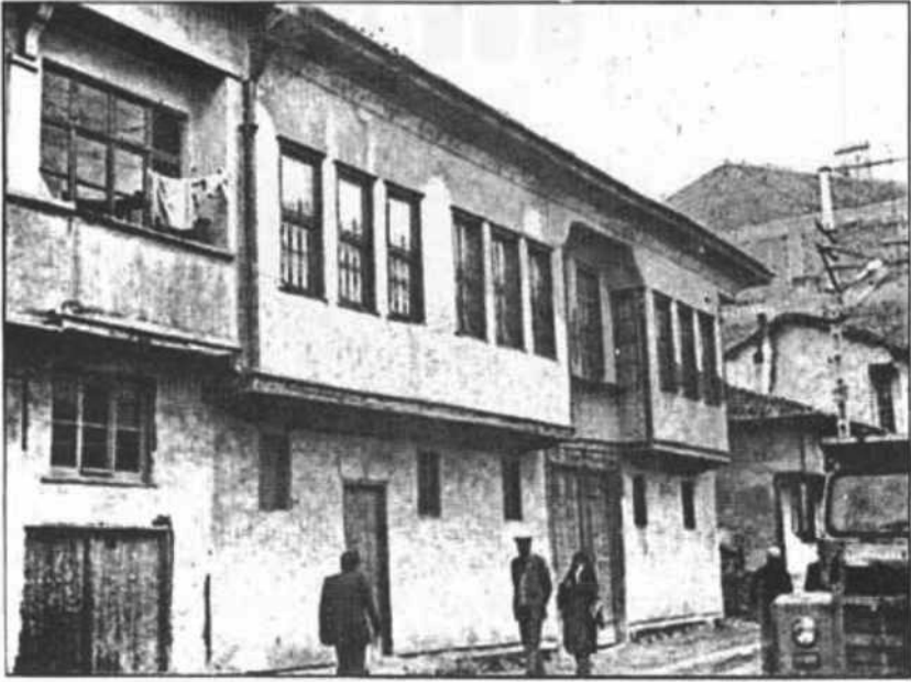
ŞEKİL 20: Üçdutlar Mahallesi Osmancık Sokağı üzerinde 20. Yüzyıl başlarında yapılmışkonutlar.
