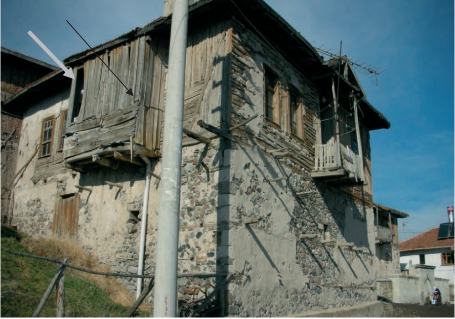
Resim184 - Ankara-Çeltikçi, evin yan bahçeye bakan kesimine çıkmalı olarak yapılan tuvalet mekânı. (Atıklar bir boru vasıtasıyla aşağı inmekte)
