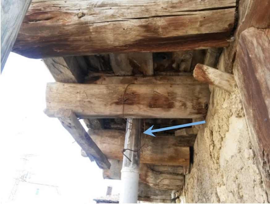
Resim 196 - Çankırı, Çerkeş Yoncalı köyündeki evin çıkmalı tuvaletinin gider borusu
