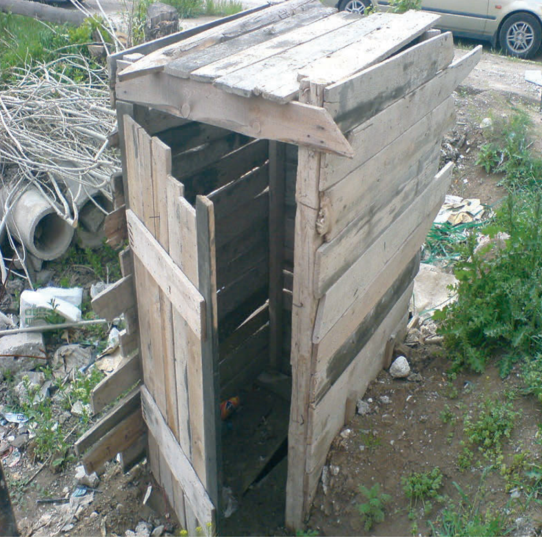
Resim 170 - Bir inşaat alanında işçilerin kullanımı için tahtadan yapılmış tuvalet.
