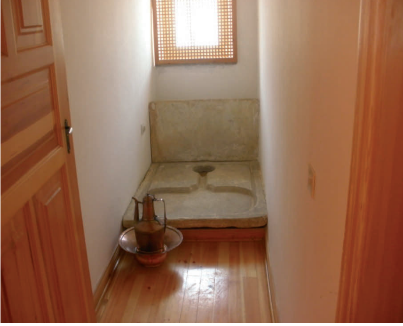
Resim 152 - Kosova-Prishtine Sultan Murat Türbesi Selamlık Binası tuvaleti.
