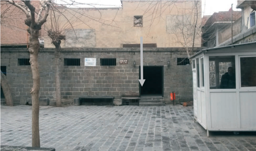
Resim 114 - Diyarbakır, Melik Ahmet Paşa Camii avlusundaki tuvaletlerin girişi.
