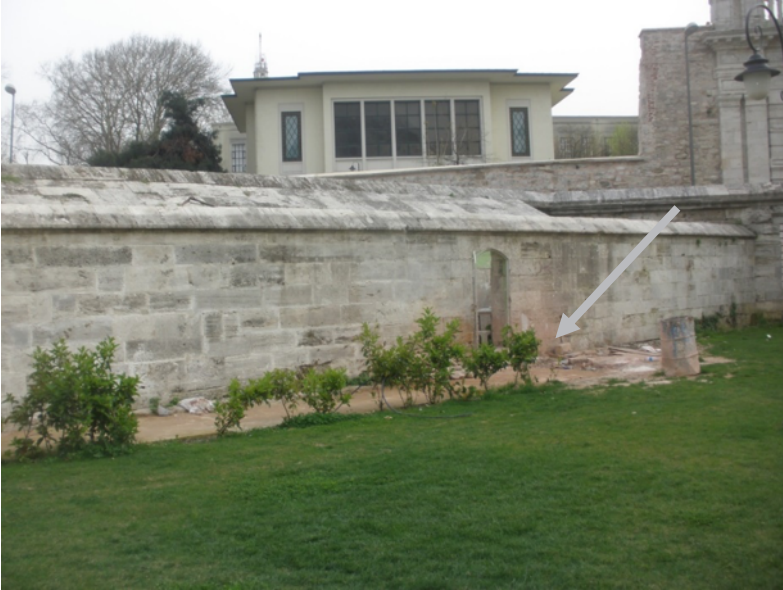
Resim 107 - İstanbul Süleymaniye Camii avlusundaki tuvalet mekânları girişi. (Fotoğraflar 2014 yılında, restorasyonun devamı sırasında çekilmiştir)
