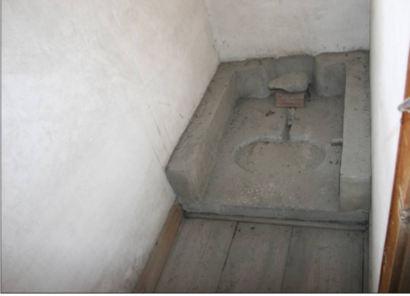
Resim 189 - Kastamonu il merkezindeki, onarılmakta olan bir yapının tuvaleti
