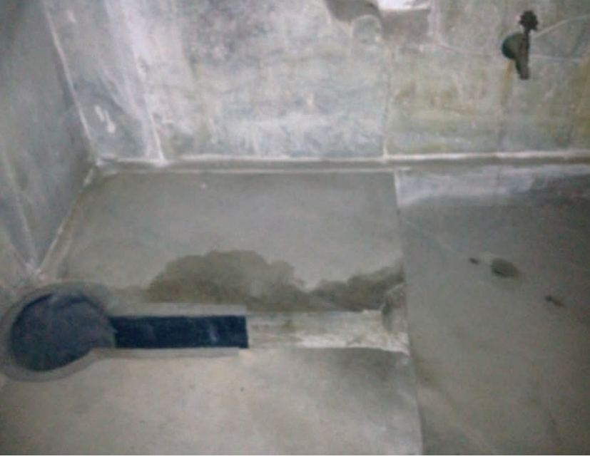
Resim 148 - İstanbul-Küçüksu Kasrı, bodrum kat tuvaleti.
