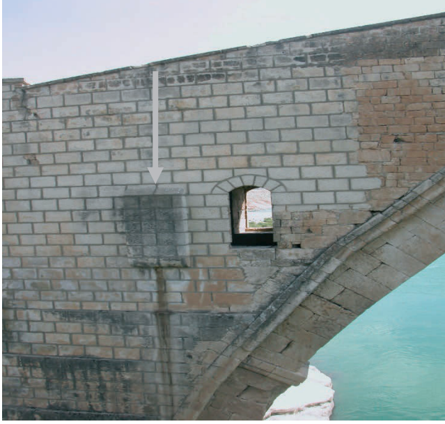
Resim 70 - Malabadi Köprüsü kaynak tarafındaki tuvalet çıkıntısı ve pencereler.
