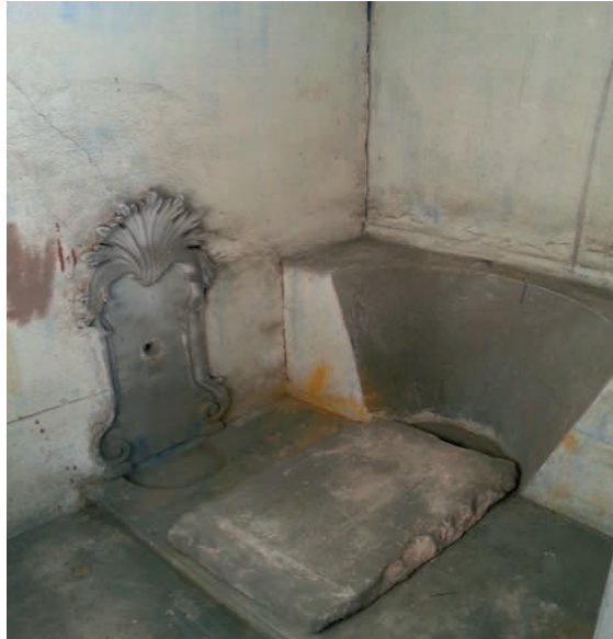
Resim 101 - Topkapı Sarayı III. Osman Köşkündeki tuvalet (Onarım sırasında)
