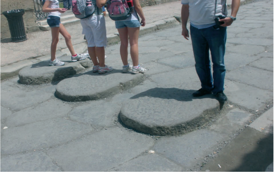
Resim 46 - Pompei; dışkıya bulaşmamak için bir kaldırımdan diğerine geçiş taşları.
