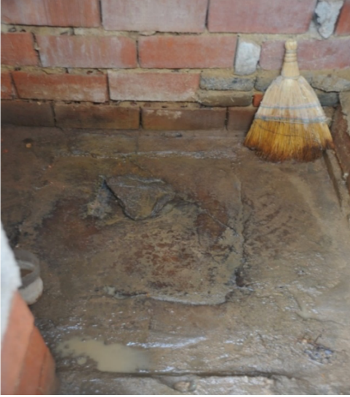
Resim 28 - Hasandede 'deki Tuvalet (kullanım sonrası gerekli temizlik yapıldıktan sonra tuvalet deliği yassı bir taş ile kapatılıyor.)
