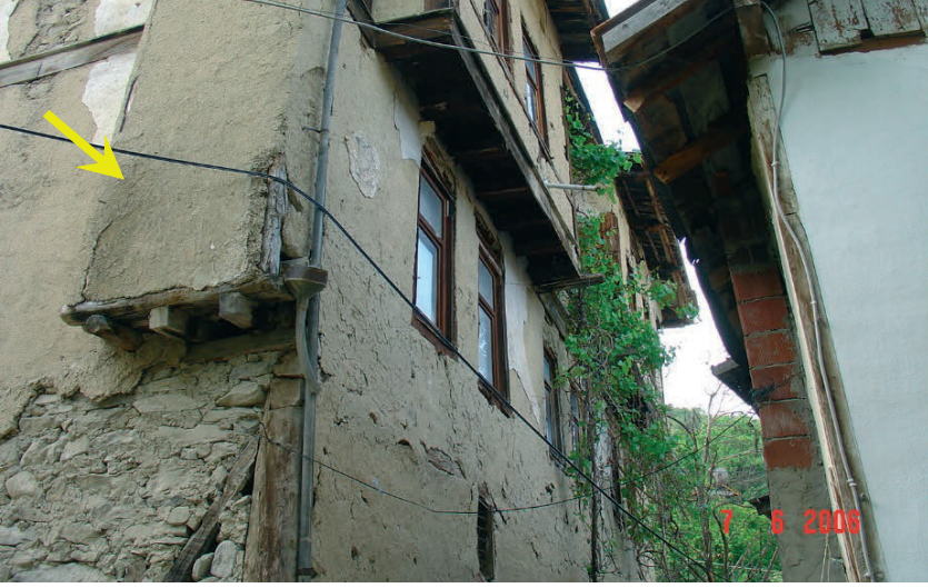
Resim 187 - Bolu-Göynük; yapının yan duvarına çıkmalı olarak yapılan tuvalet mekânı.
