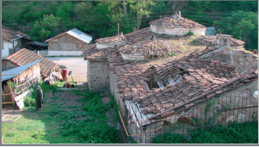
Resim 103 - Bolu-Yeniçağa'da metruk durumda bulunan Yıldırım Beyazıt Hamamı
