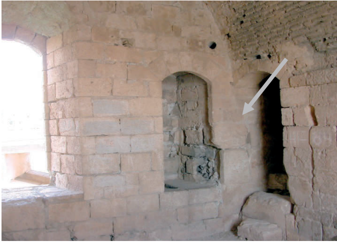
Resim 68 - Malabadi Köprüsündeki Oda ve tuvalet girişi
