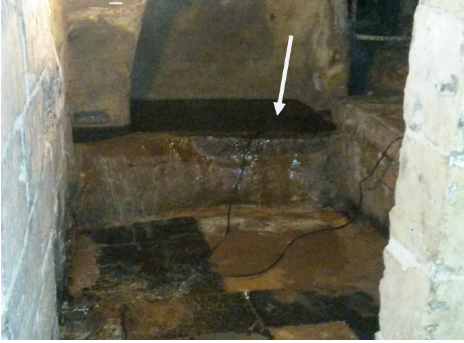
Resim 92 - Gaziantep Pişirici Kastelindeki Hamam (Bekâr Hamamı) bölümü
