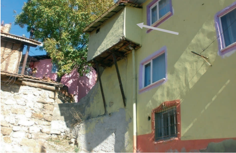
Resim 188 - Kastamonu merkezde bir evin üst katında, çıkıntılı olarak yapılan tuvalet.
