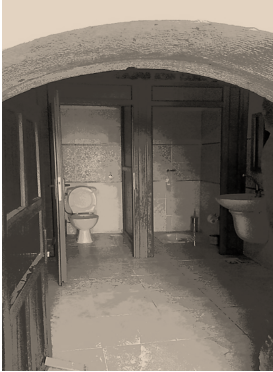
Resim 96 - Aksaray, Zinciriye Medresesinin yenilenen tuvaleti
