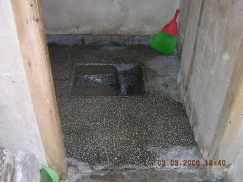
Resim 191 - Çorum-İskilip ilçesindeki 1890 yıllarına tarihlenen Dökmeciler Konağındaki helâ.
