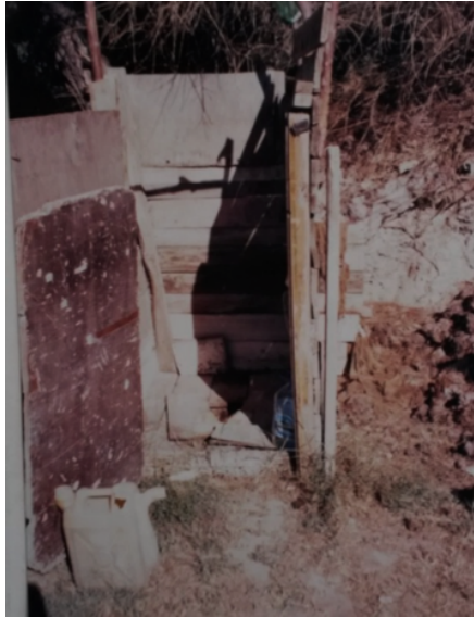
Resim 177 - Ağaçlı Köyündeki Tuvalet (açılan bir çukur üzerine ortası delik bir tahta oturtulmak suretiyle yapılmıştır)
