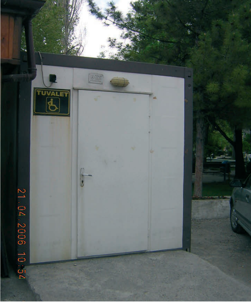
Resim 269 - Beypazarı Eski Belediye Binası yanındaki özürllü tuvaleti.
