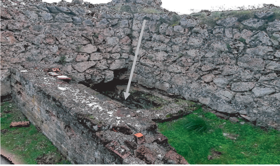
Resim 80 - Konya-Beyşehir Kubad-Abad Sarayı Tuvalet mekânı.
