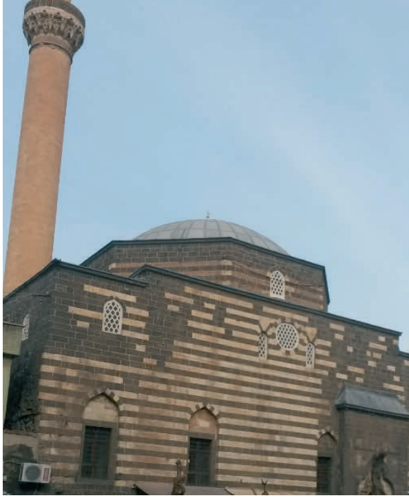
Resim 113 - Diyarbakır, Melik Ahmet Paşa Camii
