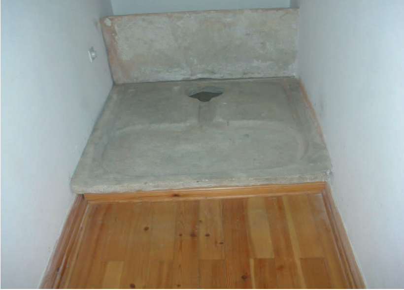
Resim 151 - Kosova-Priştine Sultan Murat Türbesi Selamlık Binası tuvaleti.
