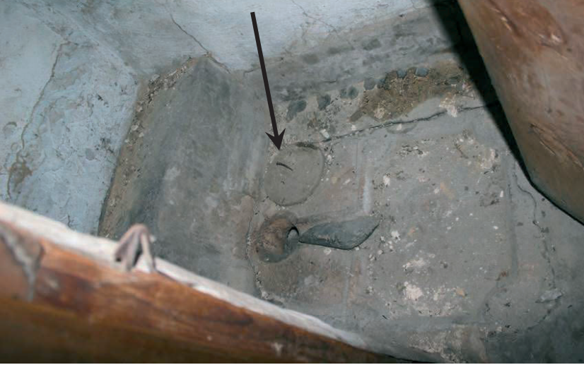
Resim 190 - Kastamonu il merkezi onarılmakta olan yapının bir başka tuvalet. (Tuvalet deliğinin yanında, kullanım sonrası deliği kapatmak için kullanılan madeni kapak görülüyor)
